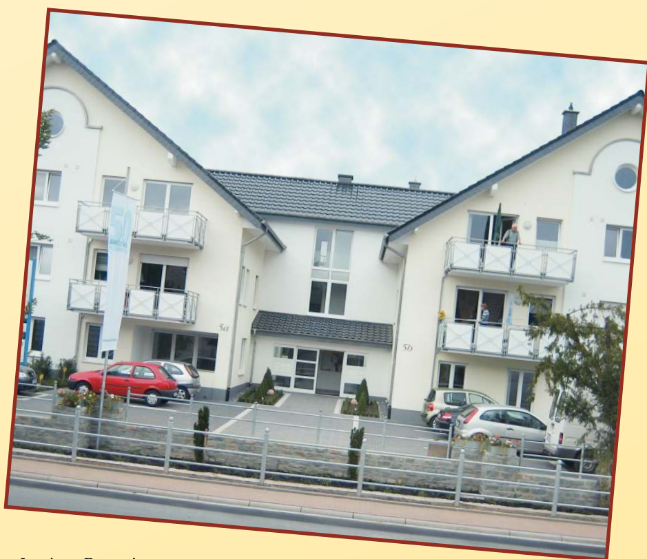
In einer Bauzeit von 13 Monaten sind 37 Wohnungen entstanden, mit Wohnflächen zwischen 54 und 92 Quadratmetern.
